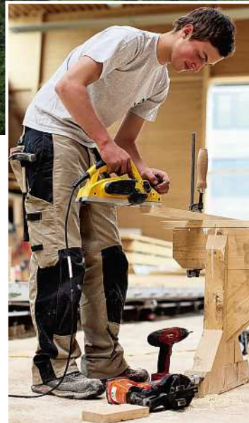
Gearbeitet wird im Team in Werkstätten und auf Baustellen.
