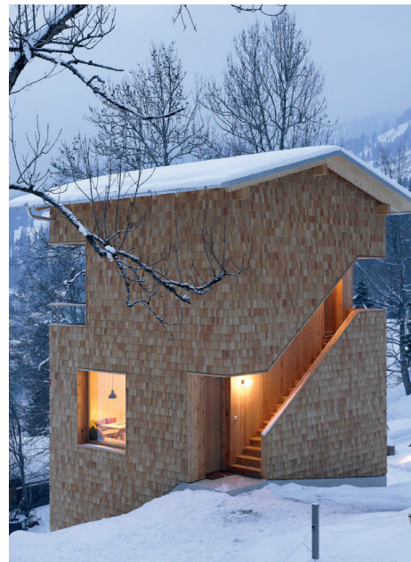
Umbau und Erweiterung Tannerhof Bayrischzell, Florian Nagler Architekten Foto: Stefan Müller-Naumann
