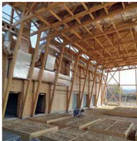
© Stroheinsatz im Bauwesen / Arbeitsbereich Holzbau UNI Innsbruck
