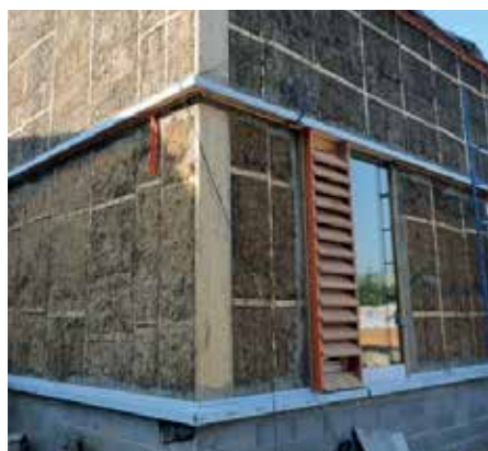
© Stroheinsatz im Bauwesen / Arbeitsbereich Holzbau UNI Innsbruck
